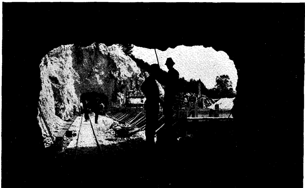
I lavori a Postumia nella primavera del 1927. - Nuova breve galleria artificiale che da tergo del Ristorante sboccherà direttamente nel primo « Grande Duomo ».
